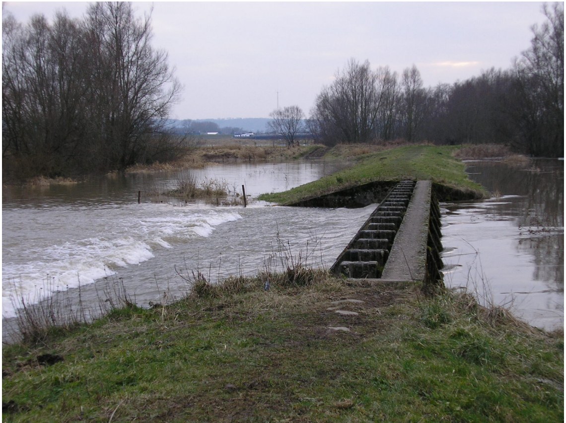
Afbeelding 15 Overlaat in de kade ten westen van de toegangsweg [Foto: DLG]
