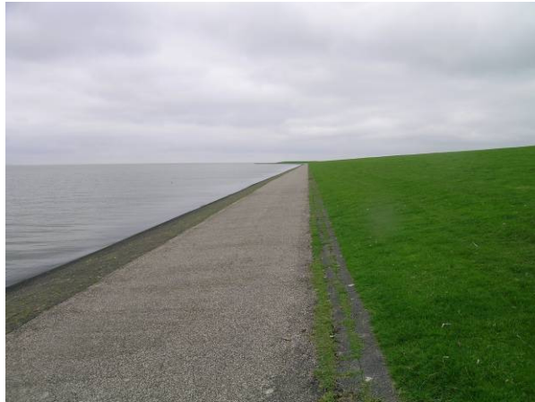
Afbeelding 4.1. Visualisatie teen (1), ondertalud (2), buitenberm (3), boventalud (4)
