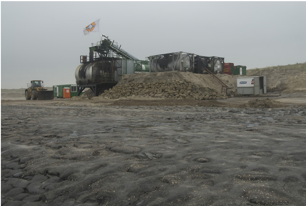
Afbeelding 1.1. Voorbeeld van een mobiele asfaltcentrale bij dijkversterking
