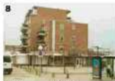
Functie: woonflat Aantal lagen: 6 Locatie: centrum Beeld: ruimteverhouding klopt, past bij het centrum
