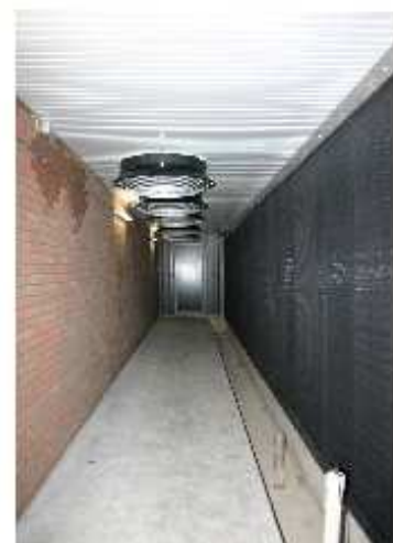
Figuur 4.5 Standaardopstelling gecombineerd luchtwassysteem(BWL 2007.01V1)
