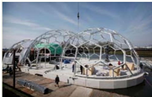
Drijvend paviljoen in aanbouw in de Heijsehaven.
