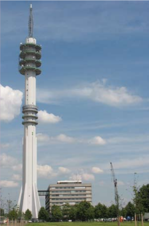
Zendmast op Waalhaven Zuid
