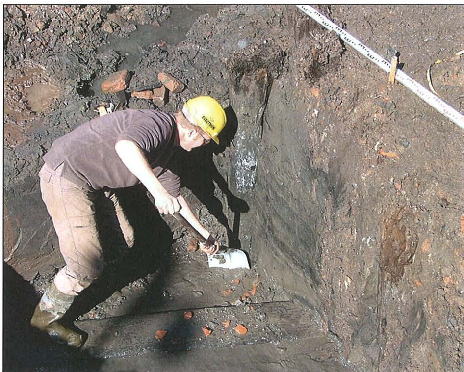
Figuur 7. Liggende balken/palen op grote diepte onder de havenbrug.
