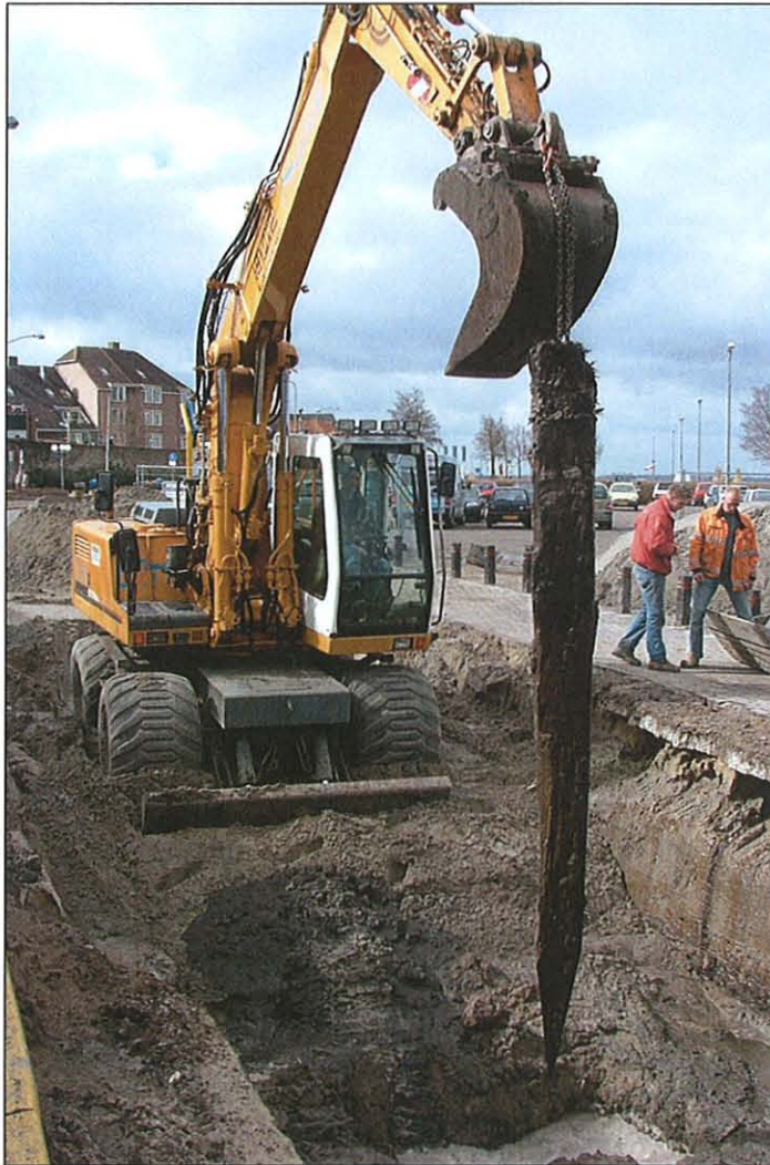
Figuur 10. Berging van paal/spoor 11 in werkput 2.
