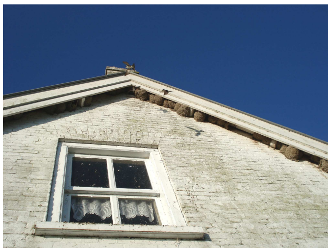
Foto: Huiszwaluwnesten onder de dakgoot bij Amaliahoeve
