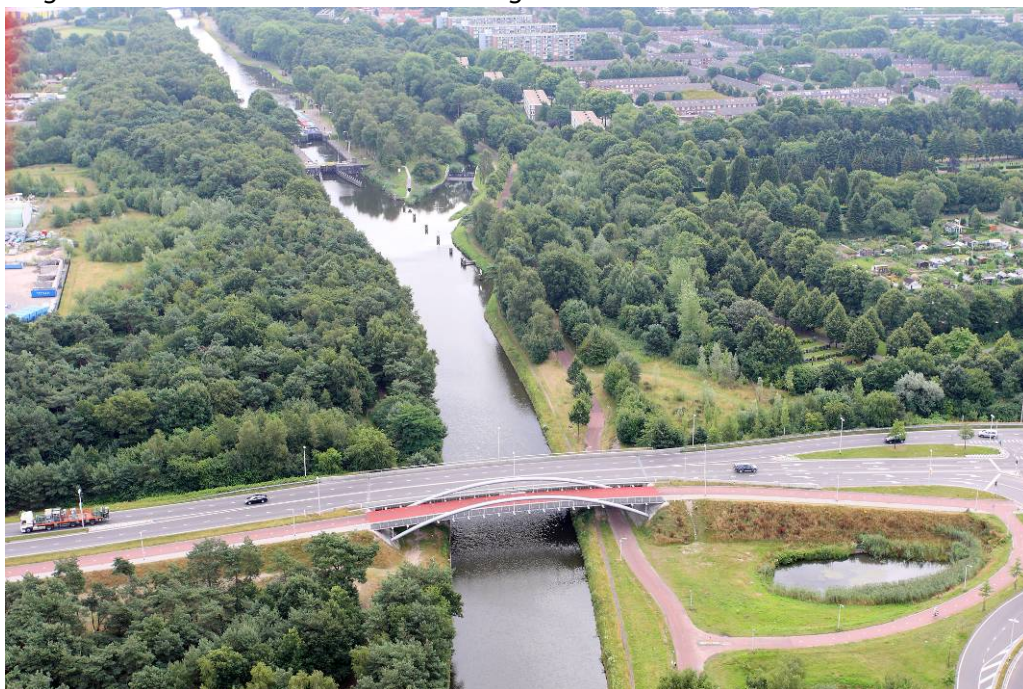
Figuur 3.5 Na de Burgemeester Baron van Voorst tot Voorstweg buigt het voor sluis III het Wilhelminakanaal enigszins af. Het maaiveld rondom het Wilhelminakanaal stijgt hier, waardoor het kanaal verdiept ligt.
