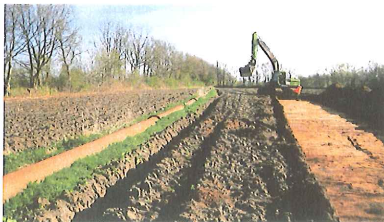
Figuur 5. Drogeham Zandwinning, It Heechsân. Een overzicht van de werkzaamheden, met aan de linkerkant de zandzuigerbuis die het veld doorkruist (zie ook Figuur 4 en 5), rechts de aanleg van sleuf 1. De foto is genomen vanuit het zuidwesten, richting het noordoosten.
