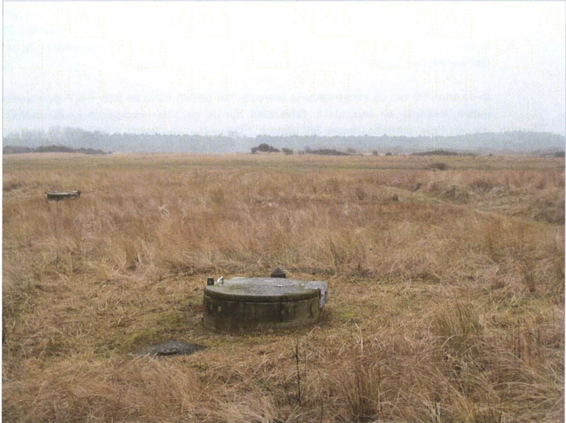
Figuur 12 - Aan maaiveld is van DWAT niet meer te zien dan putdeksels
