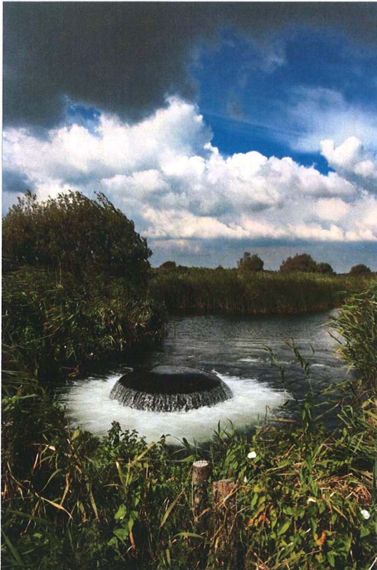
Figuur 4 - De inlaat van voorgezuiverd IJsselmeer- en Rijnwater in infiltratiegebied Castricum
