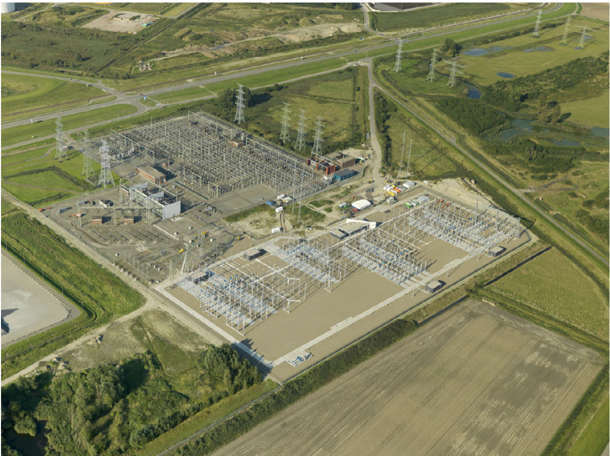
Figuur 8: Impressie van 150kV en 380kV station Borssele (TenneT)
