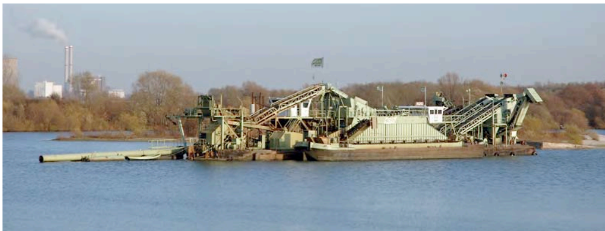
Voorbeeld van de dimensies van het in te zetten drijvende winwerktuig. Er worden geen installaties en depots op de wal aangelegd.
