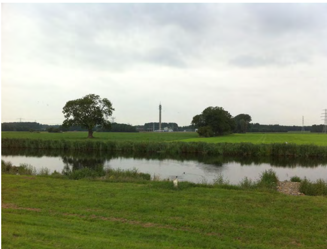
Afbeelding 15 Huidige situatie hoogspanningsstation vanaf fietspad ten zuiden van de Oude IJssel
