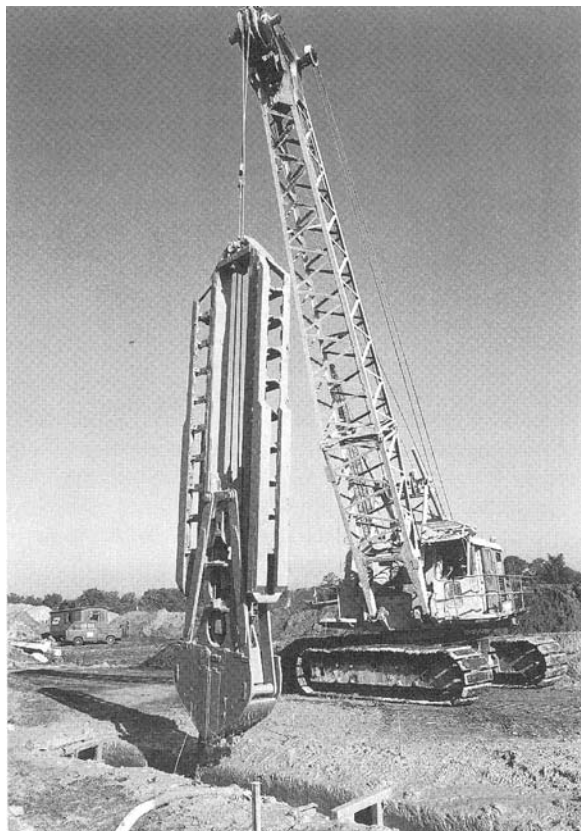
Cement-bentoniet scherm in uitvoering (bron CUR 189)
