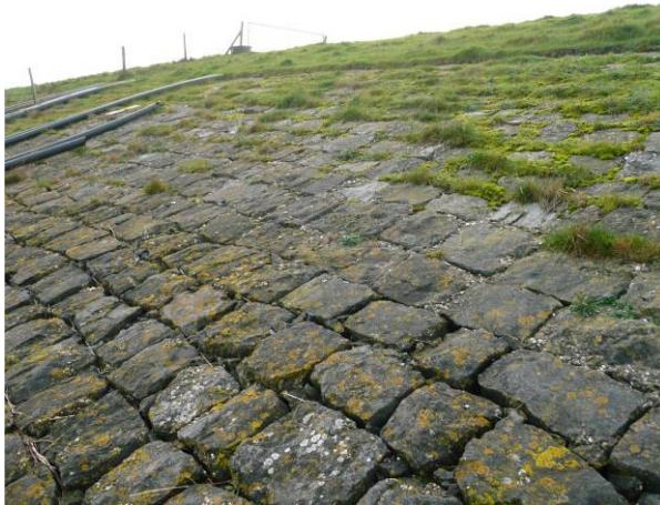
Figuur 2.1 Detail steenbekleding van de Wieringermeerdijk
