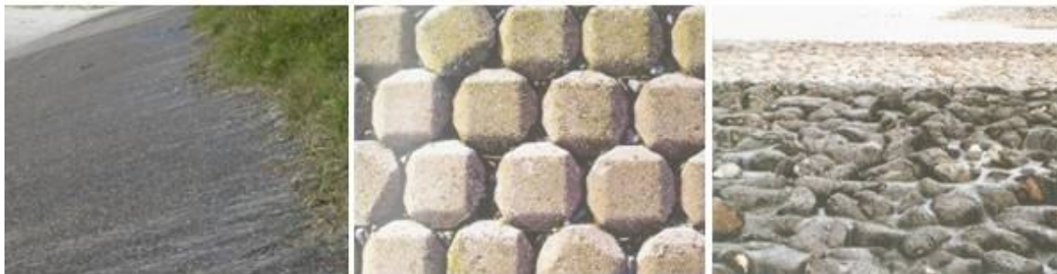
Figuur 3.3 Bekledingsvarianten (v.l.n.r. asfalt, betonzuilen, ingegoten breuksteenoverlaging)
