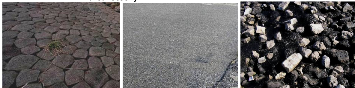
afbeelding 3.3. Bekledingsvarianten (v.l.n.r. betonzuilen, asfalt, gepenetreerde breuksteen)
