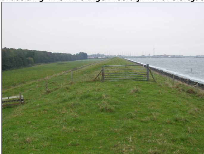
afbeelding 4.13. Wieringermeerdijk vanaf Sluitgatdijk richting Den Oever
