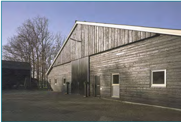
Zadeldak, topgevel met hout bekleed
