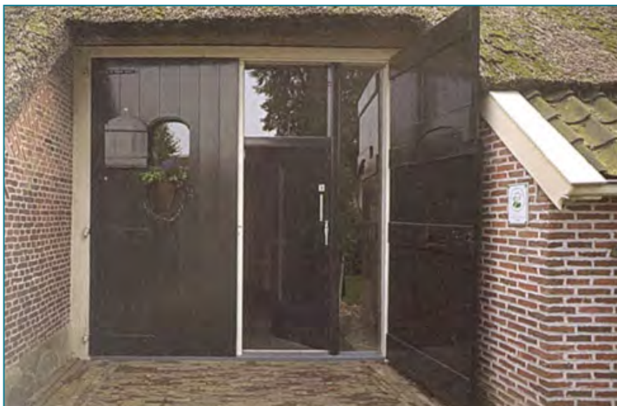
Verbouw van het oorspronkelijke hoofdgebouw
