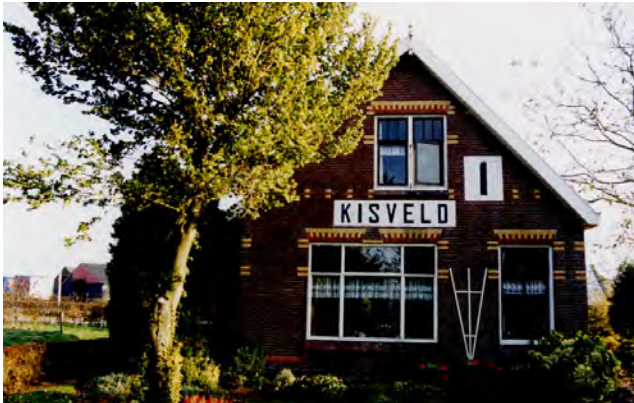
Voormalig stationsgebouw in Kisveld.
