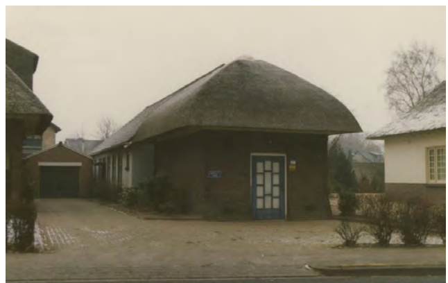
Trafohuisje van de EMB in Borculo.
