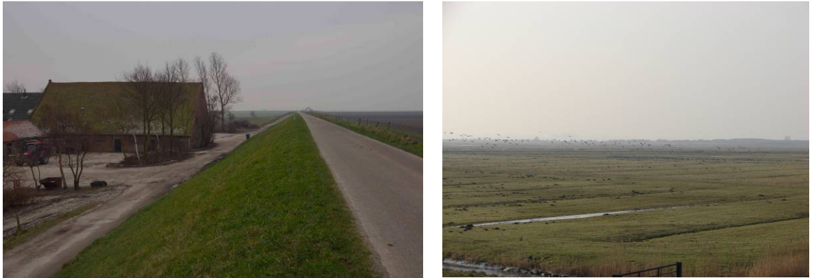
Figuur 5-2 Westdijk (km 56,8 in zuidelijke richting), Korendijkse Slikken
