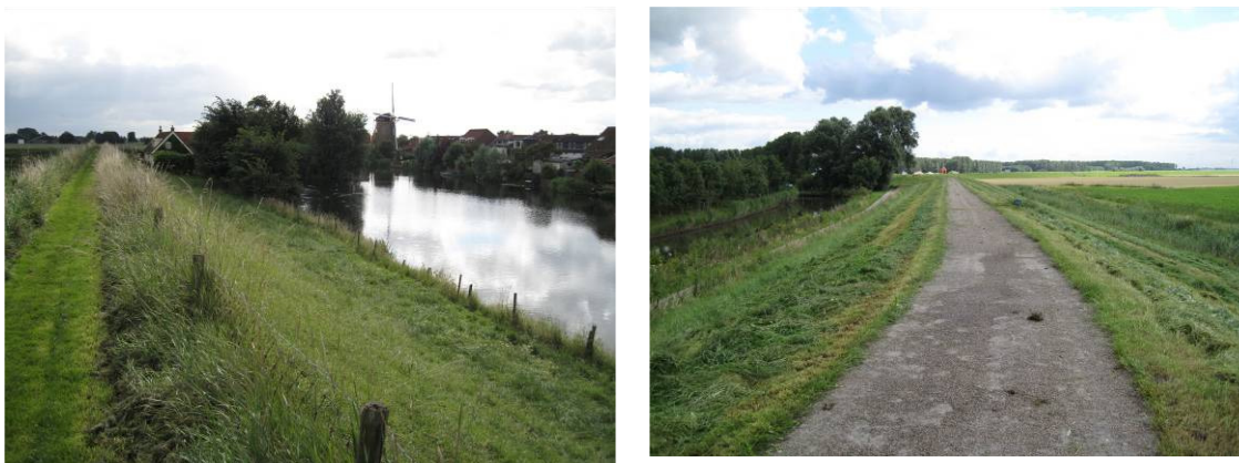
Figuur 5-5 Molenpolderdijk: bij Binnenspui (km 58,0), langs havenkanaal (km 58,4)
