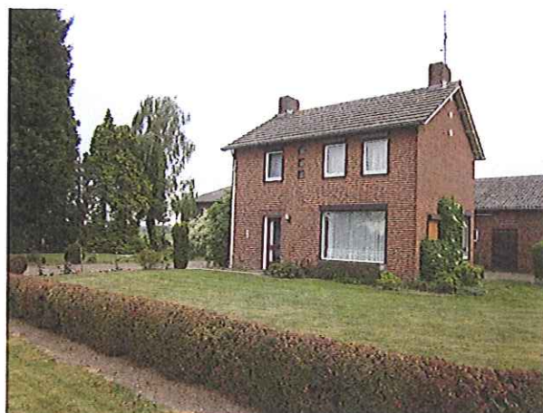
Fotonummer: 20 Omschrijving: Losbaan 1a: woonhuis
