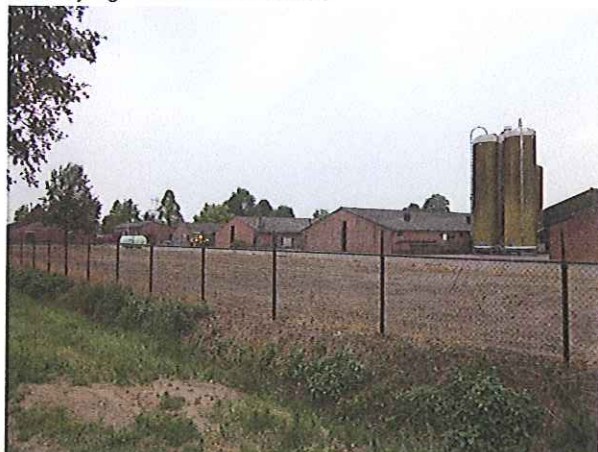
Fotonummer: 21 Omschrijving: Laagheide 9: schuren
