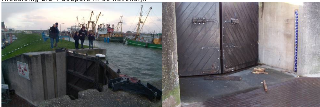
Afbeelding 2.2 : Coupure in de havendijk
