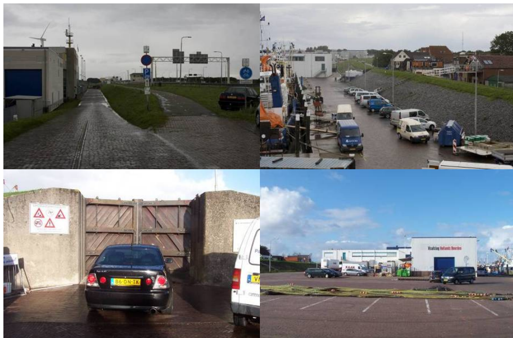
Afbeelding 3.9 : Verkeer en infrastructuur haventerrein
