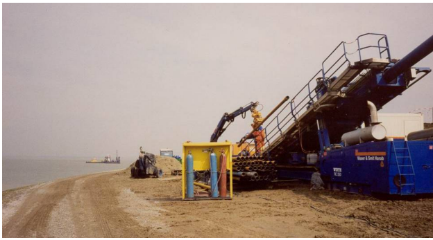
Foto B2.4 Boorstelling voor gestuurde boring
