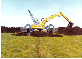
Figuur B2.3 Aanleg in den droge
