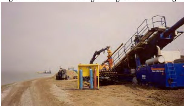
Figuur B2.10 Boorstelling voor gestuurde boring naar open water
