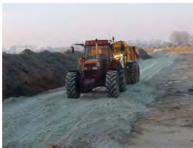
Figuur B2.1 Voorbeeld aanleg in den droge
