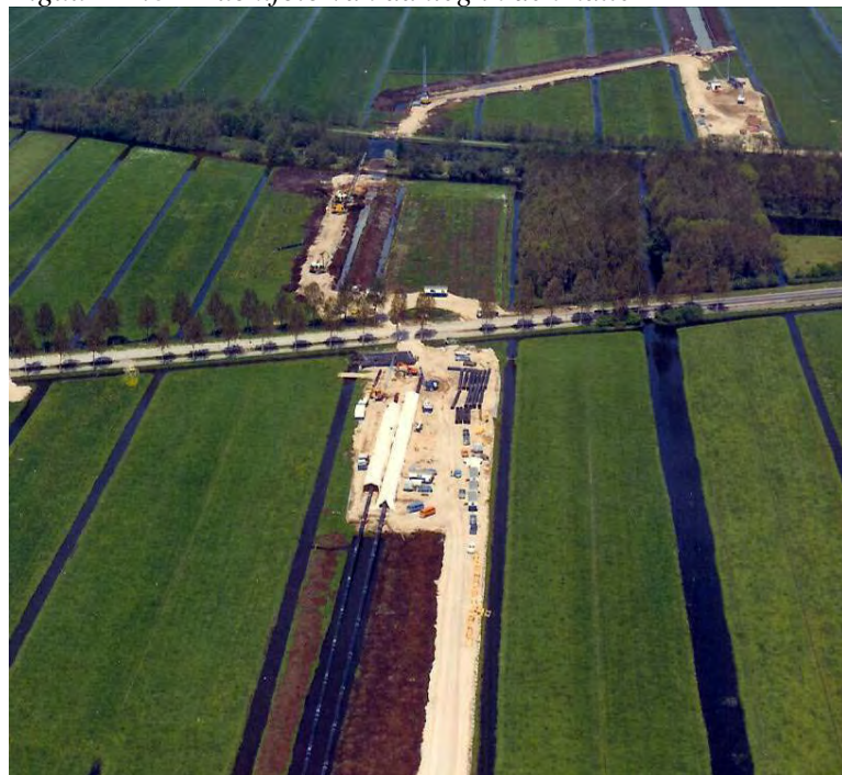
Figuur B2.8 – Luchtfoto van aanleg in den natte
