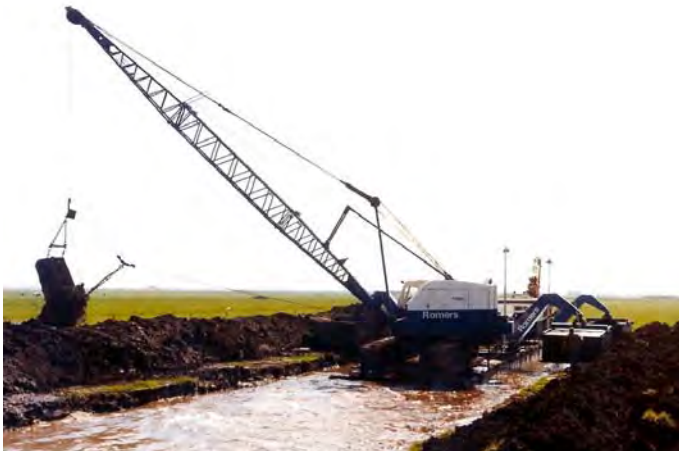
Figuur B2.5 – Graven van sleuf met dragline
