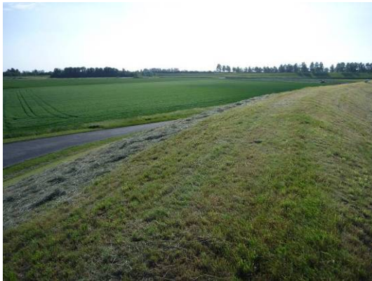
Foto 7. Pas gemaaide dijk binnenzijde
