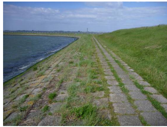
Foto 10. Buitenzijde dijk met verharding
