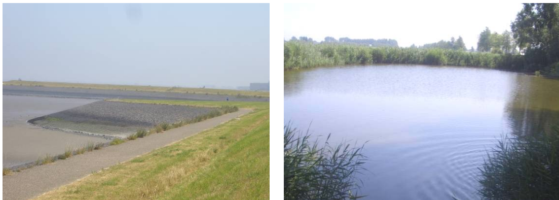
Figuur S3 Restanten van voormalige dijkdoorbraken (links de verbreding van de oostelijke Zeedijk (nol), rechts het weel langs de N689)
