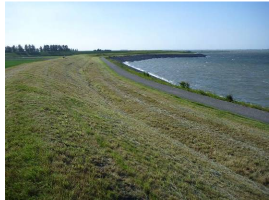
Foto 8. Pas gemaaide dijk buitenzijde
