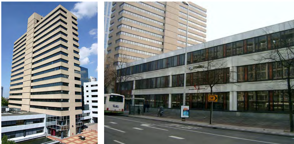
Van links naar rechts: Gebouw A (Weenapointflat), gebouw D (laagbouw aan de Weena).
