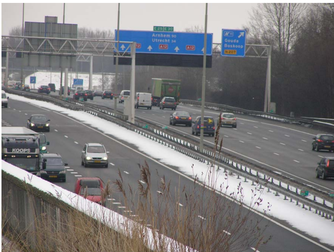
Figuur 1.3 Aquaduct Gouweknoop.
