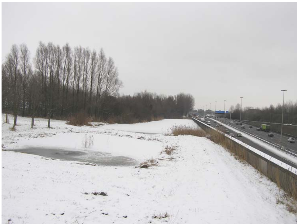
Figuur 4.1 Oostzijde aquaduct met hoog opgaande beplanting.
