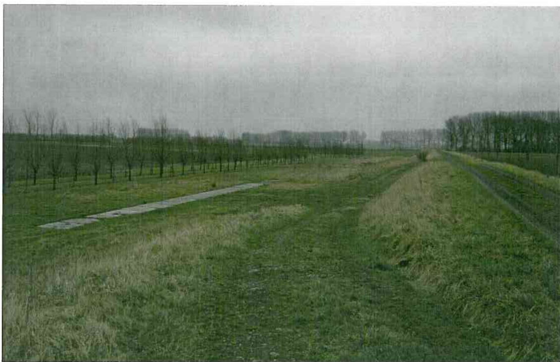
Foto 4 (img_0021): puin- en stelconverharding op perceel V 753, vanaf Nieuwehovendijk, richting het zuiden
