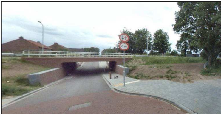
Figuur 2.1: Tunnel N348/Molenweg (bron: Cyclo Media)
