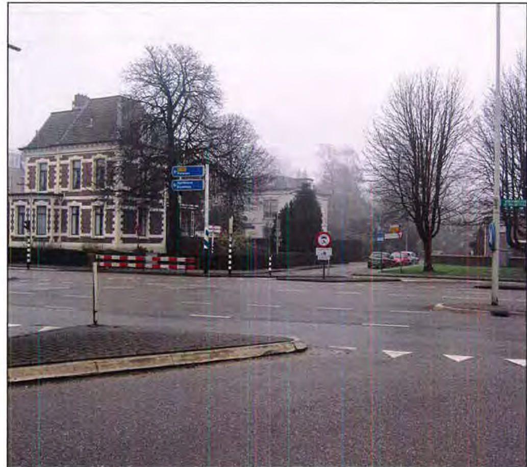
Groot verhardingsvlak bij huidige aansluiting N348 op Harderwijkerweg ter hoogte van Hoflaan, met beeldbepalende bebouwing als onderdeel van het beschermd dorpsgezicht.
