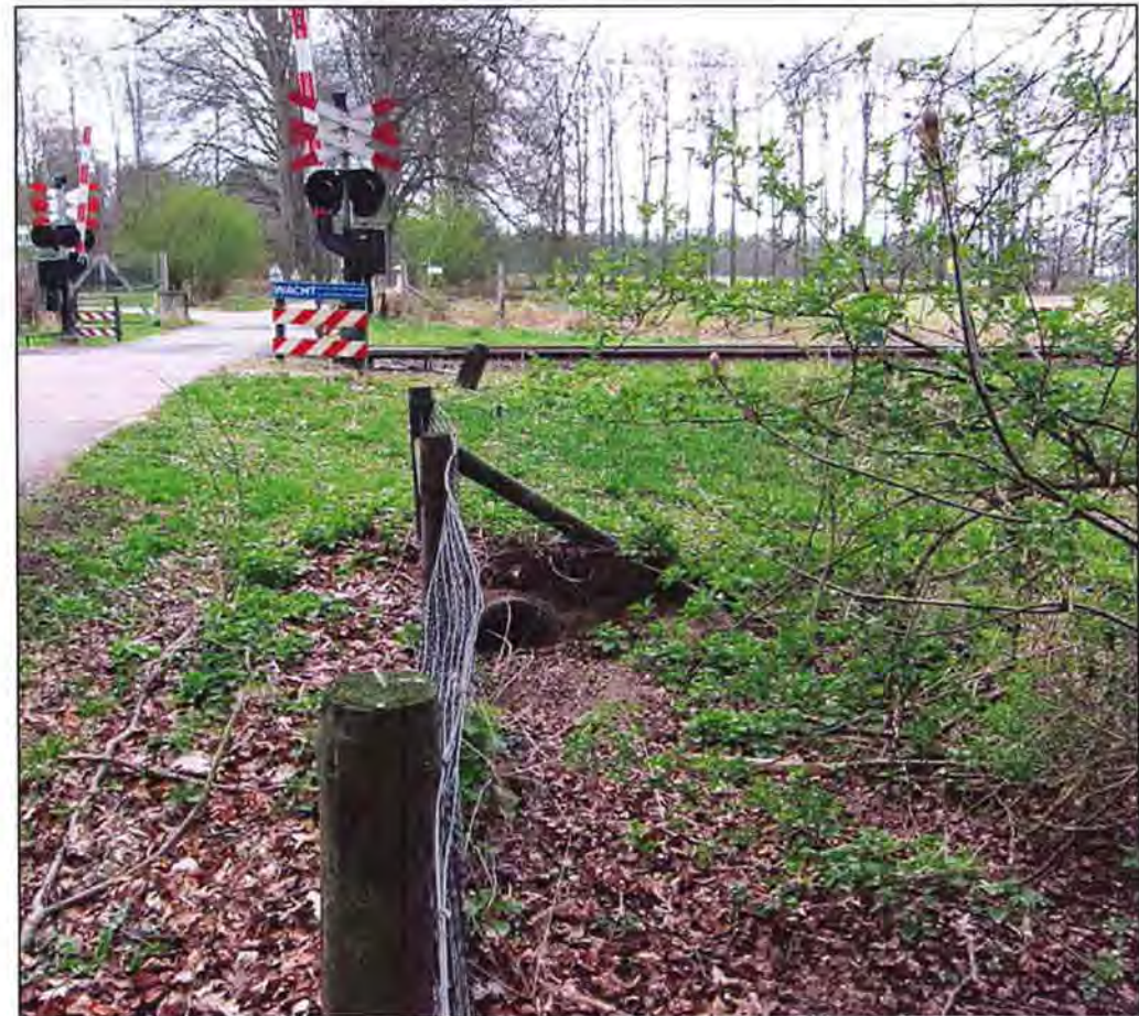
Droge, rechthoekige eco-duiker (kleine faunatunnel) met inloop (Rijkswaterstaat, 2011)
