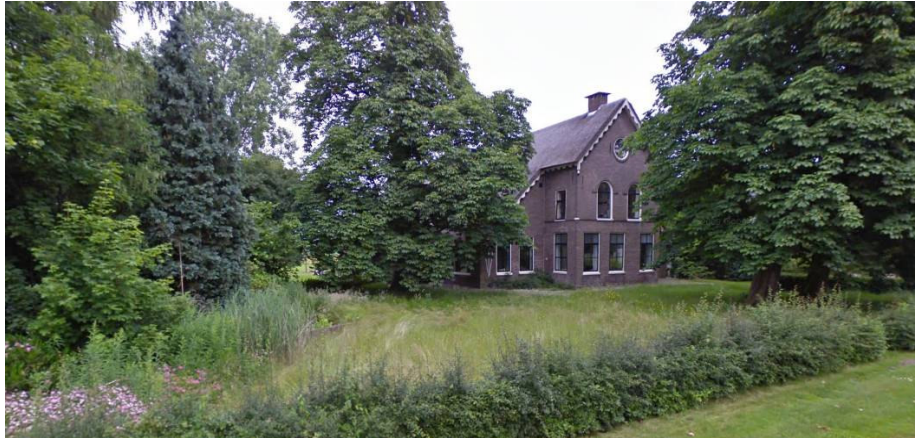
Ontginningsboerderij aan de Hoofdvaartsweg 162
