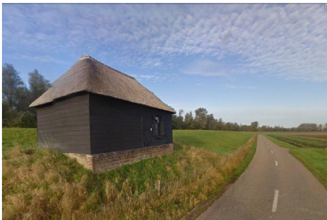
Figuur 5.2 Griendwerkershuis aan de Jeppegatweg
