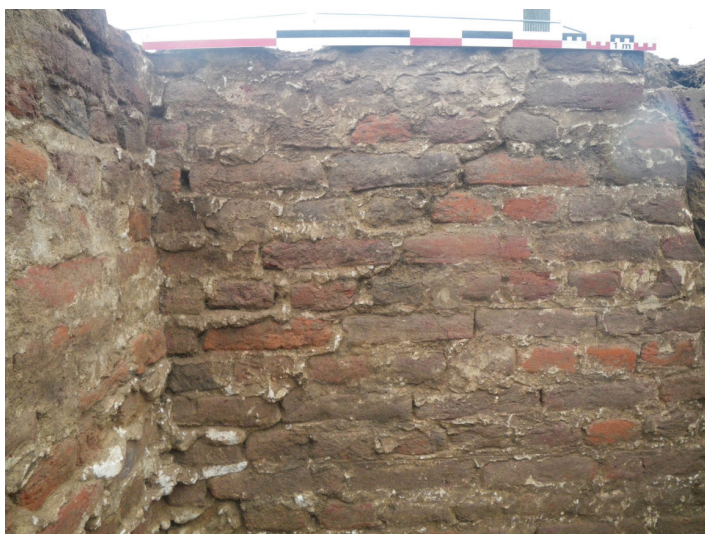
Fig. 5.12: Opbouw van het muurwerk.
