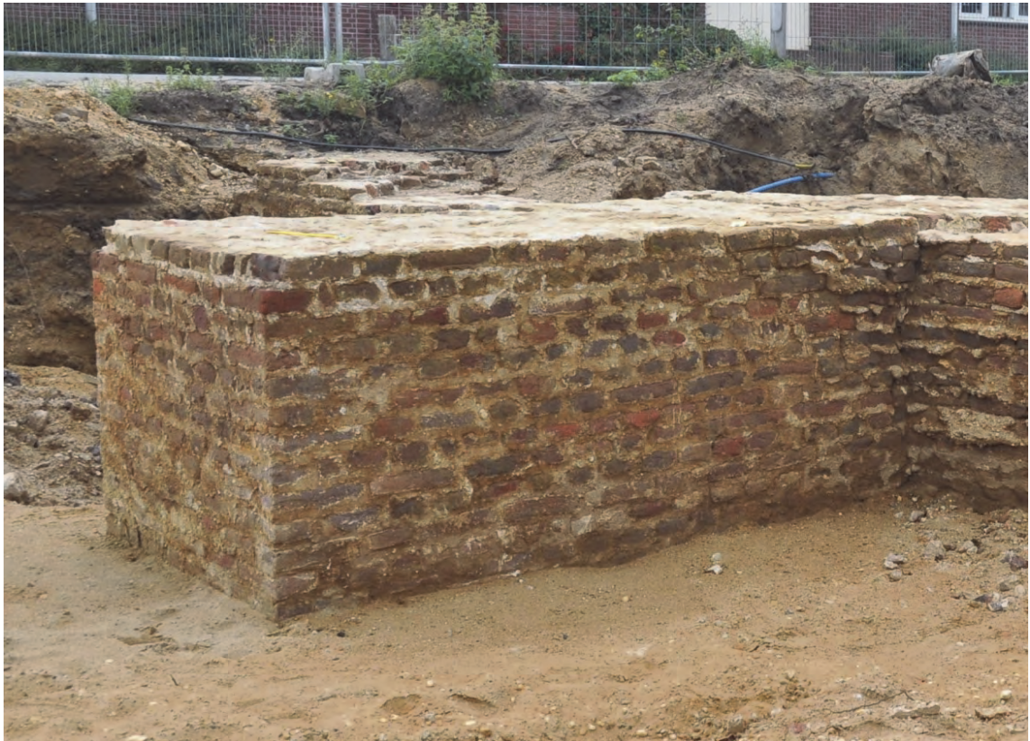
Fig. 7.8: Steunbeer uit fase 1a met rechts de diagonale bouwnaad tussen 1a en 1b.
