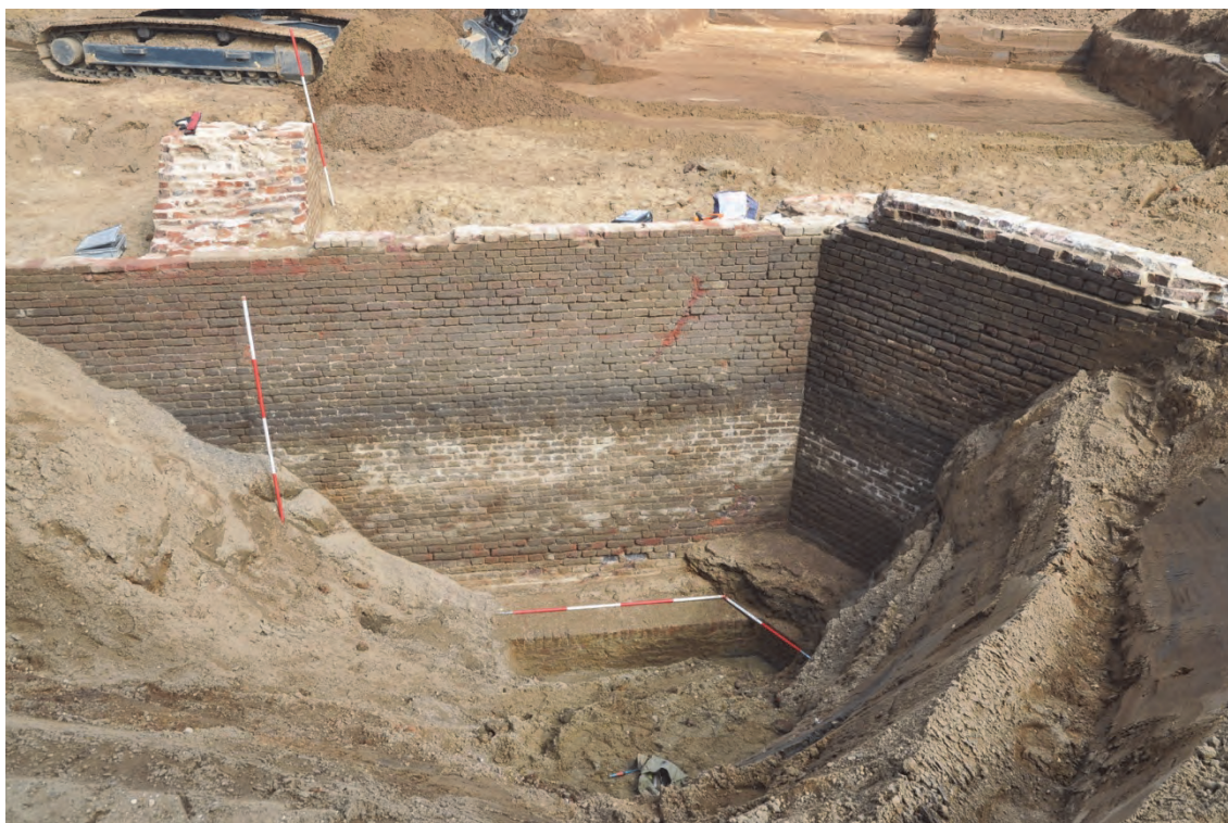
Fig. 7.23: Fundering van de courtinemuur (hoek MD5 en MD6) tussen bastion 1 en 2 (1807).
