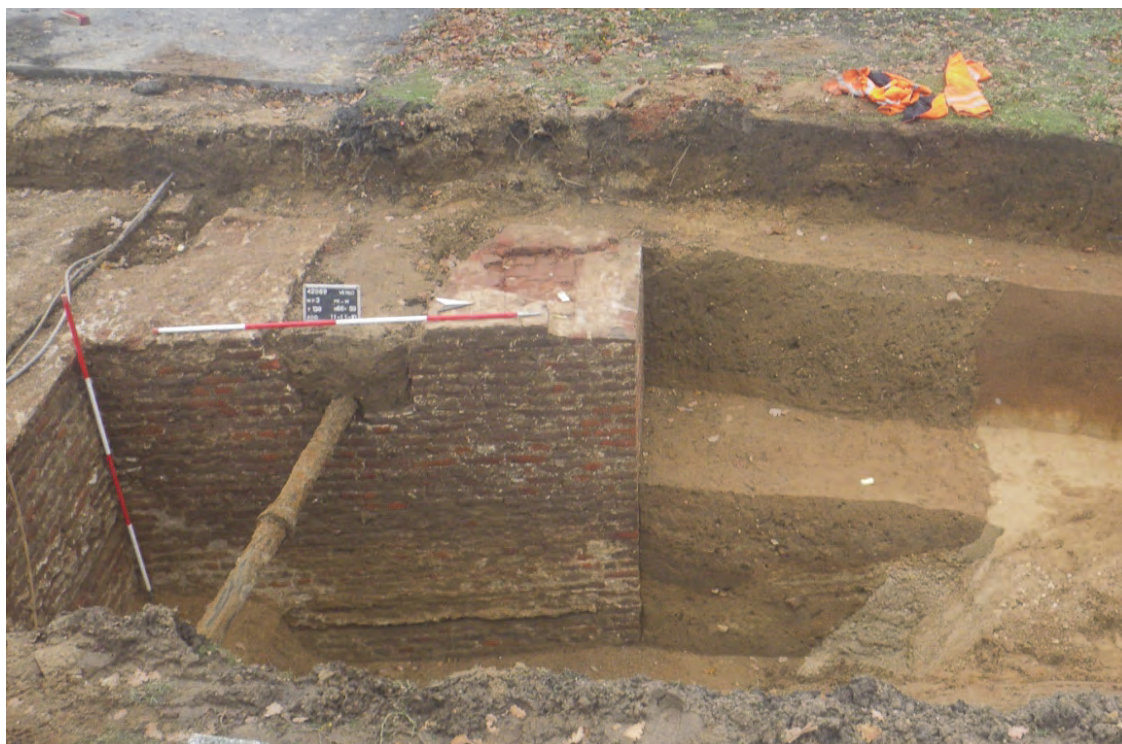
Fig. 6.7: Insteek s60 van de vestingmuur MD4.
