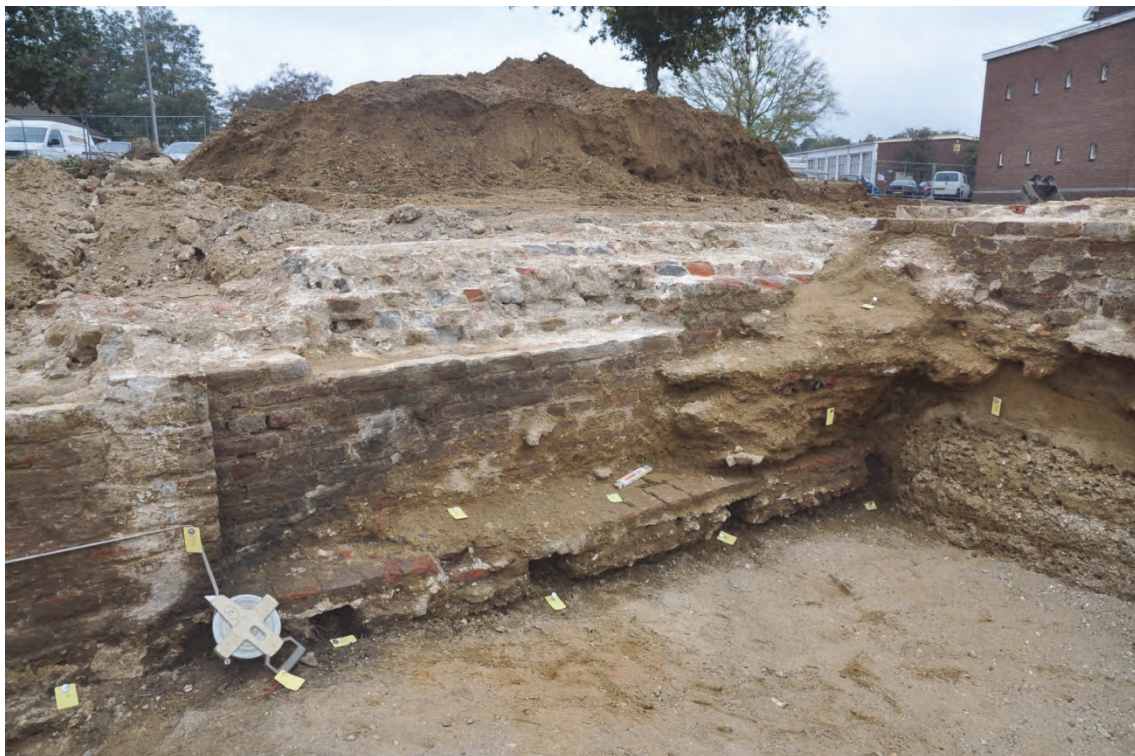
Fig. 7.19: Aanzicht van de westelijke binnenwand van de poterne.
