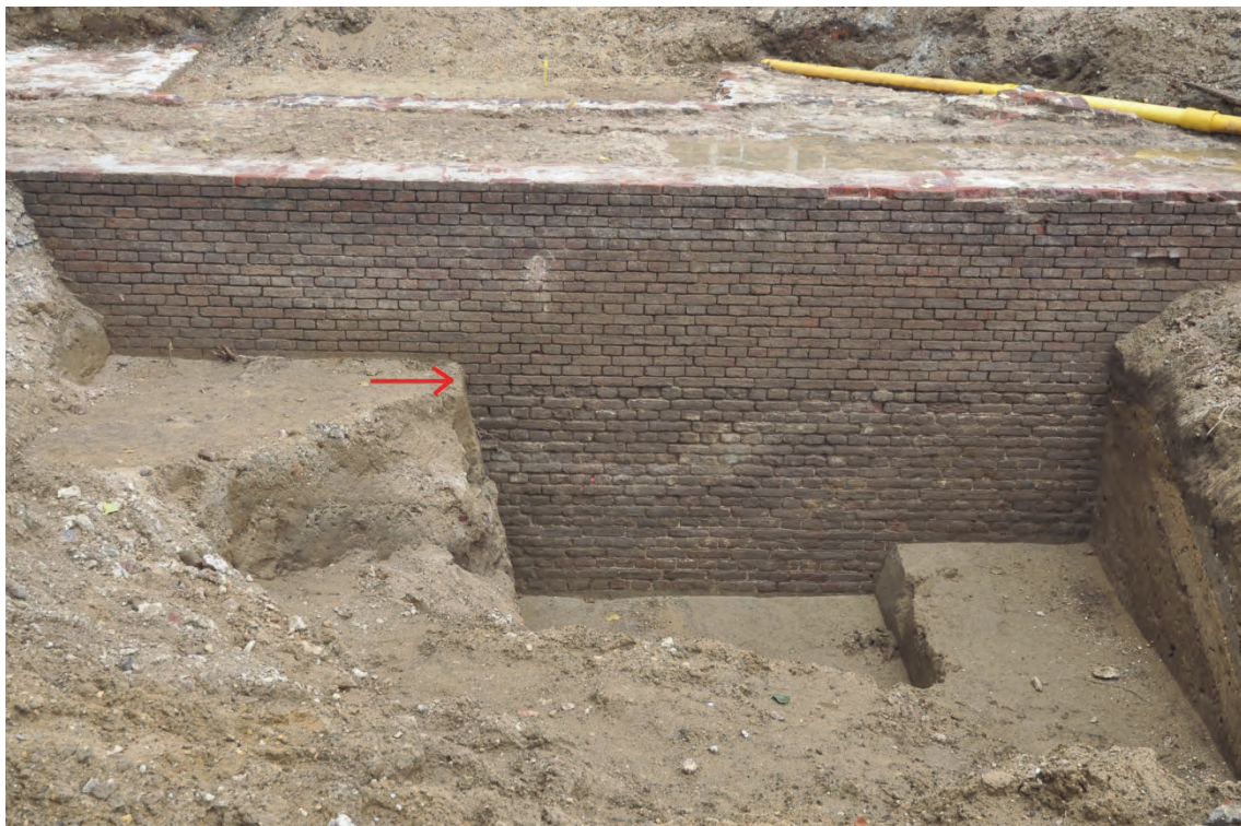
Fig. 7.15: Zuidelijke face MD8 van bastion 2, buitenmuur met onderaan oud muurwerk en boven de pijl een latere herstelling.
