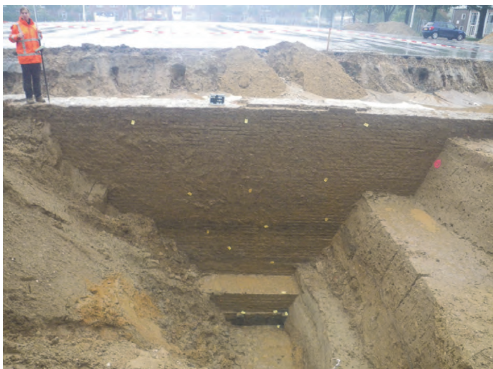
Fig. 6.31: Aanzicht van de buitenkant van MD24 met onderin de balkenfundering.
