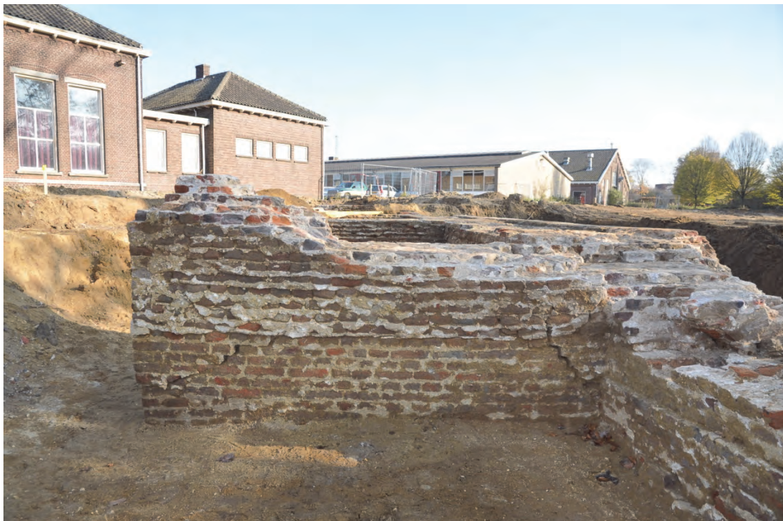
Fig. 7.11: Steunbeer van de zuidelijke face MD8 van bastion 2: fase 1b slordig gemetseld op fase 1a.
