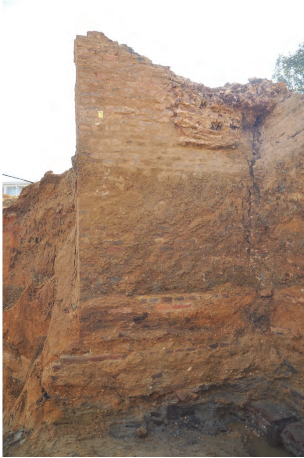
Fig. 7.10: Steunbeer van de zuidelijke flank MD12 van bastion 3 na uitgraving, beneden fase 1a, rechtsboven fase 1b.
