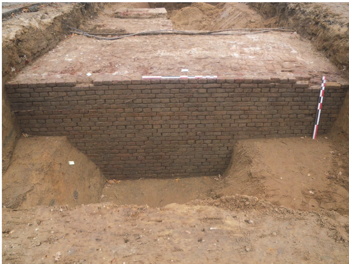
Fig. 6.8: De grachtzijde van de bastionmuur MD4, met een 19 e -eeuwse bakstenen klampmuur.
