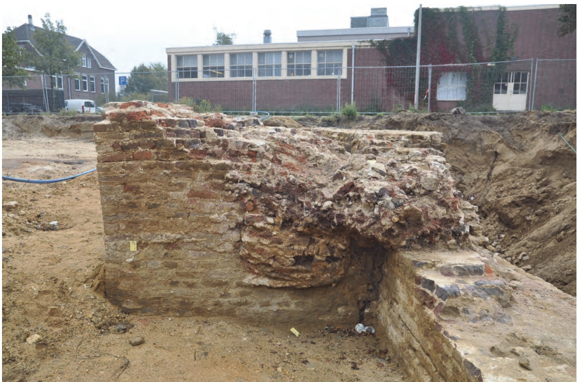
Fig. 7.9: Steunbeer van de zuidelijke flank MD12 van bastion 3: ter aanvulling van fase 1a is er baksteenpuin in de diagonale bouwnaad gestort in fase 1b.
