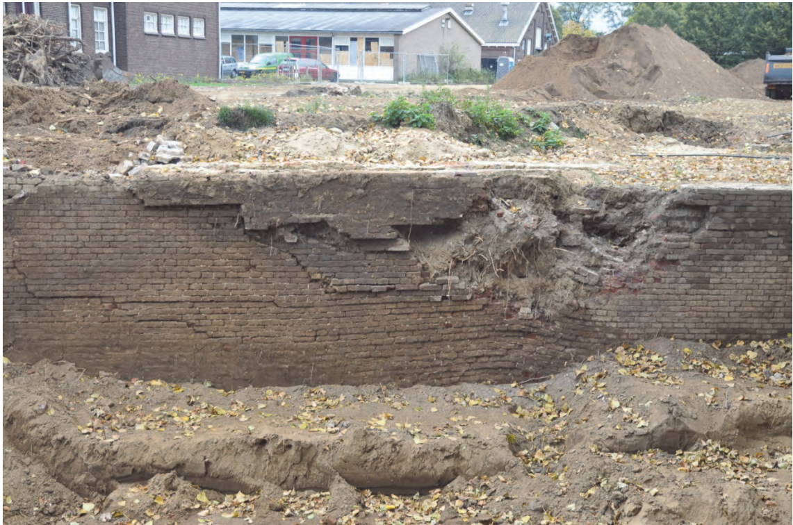
Fig. 7.24: Westelijke schildmuur MD9 van de face van bastion 2, schade door inslag ten tijde van WOII.
