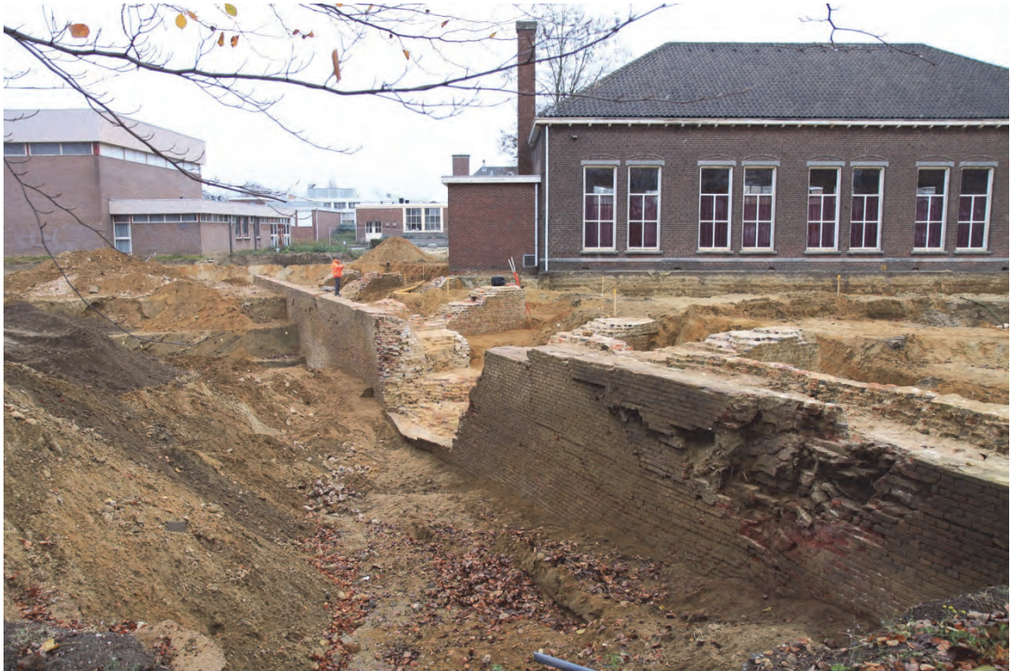
Fig. 6.56: Overzicht van MD9 met de schade die toegebracht is door twee bommen in de Tweede Wereldoorlog.
