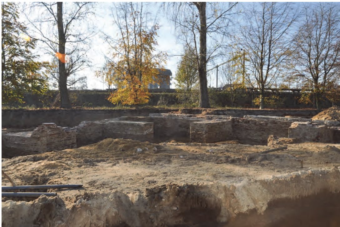
Fig. 7.3: Overzicht van de punt van bastion 2 met de schildmuren en de steunberen.
