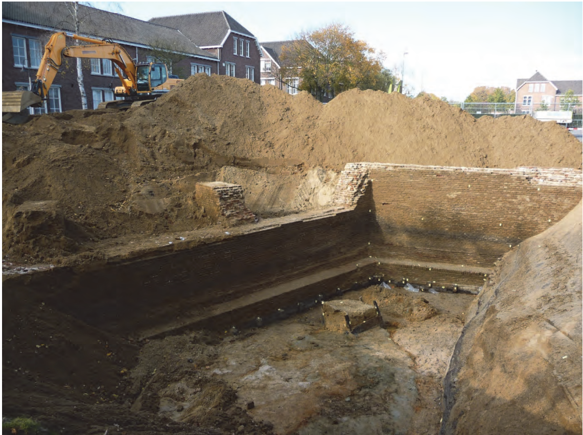
Fig. 7.20: De oostelijke courtine (MD1) en de noordelijke flank (MD2) van bastion 1, herbouwd in 1807.
