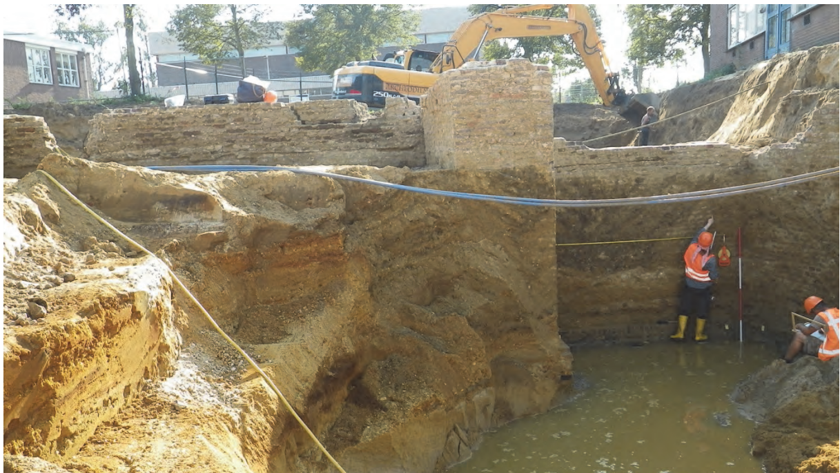
Fig. 6.19: Aanzicht van de binnenkant van MD12. De persoon tegen de muur staat op een dwarsbalk.
