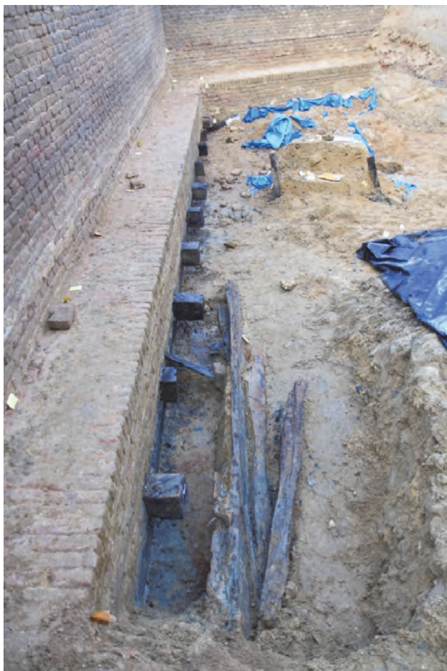
Fig. 6.55: De beschoeiing/afdamming voor het fundament van MD2 in werkput 36.
