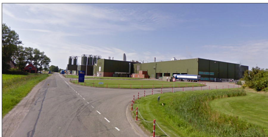
Zicht vanuit het oosten op Aviko/Rixona
