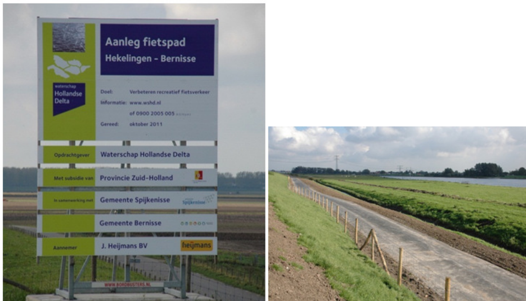
Afbeelding 43: Aanleg fietspad in uitvoering.
