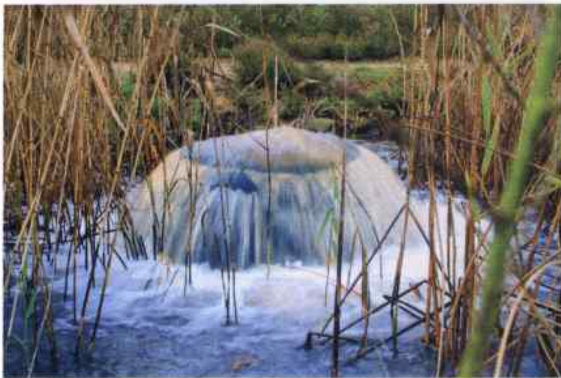
uitstroomopening infiltratievijvers
