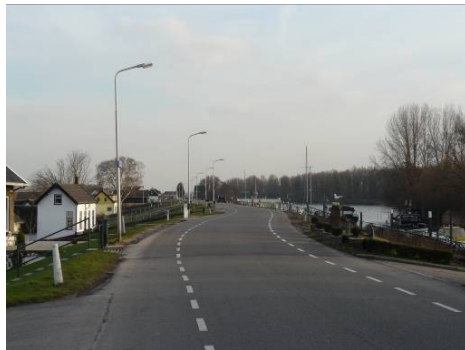
De dijk als hooggelegen, doorgaande lijn
