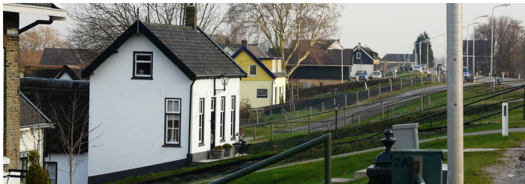
Versterkte dijk met flauw talud Molendijk/Noord
