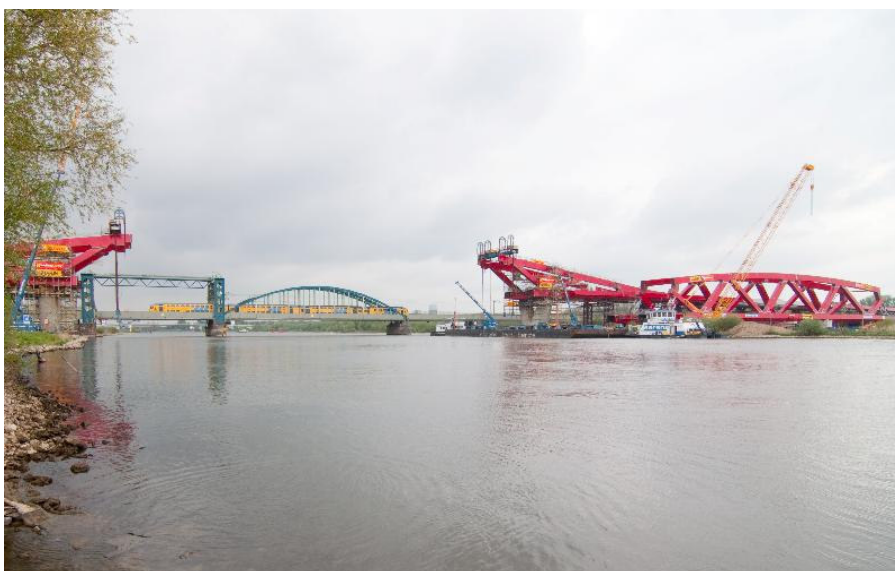
Figuur 18. Aanleg nieuwe spoorbrug Zwolle.
