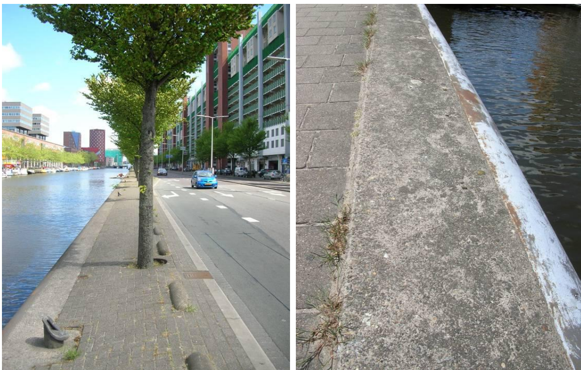
figuur 4.31 de bestaande kade en kaderand
