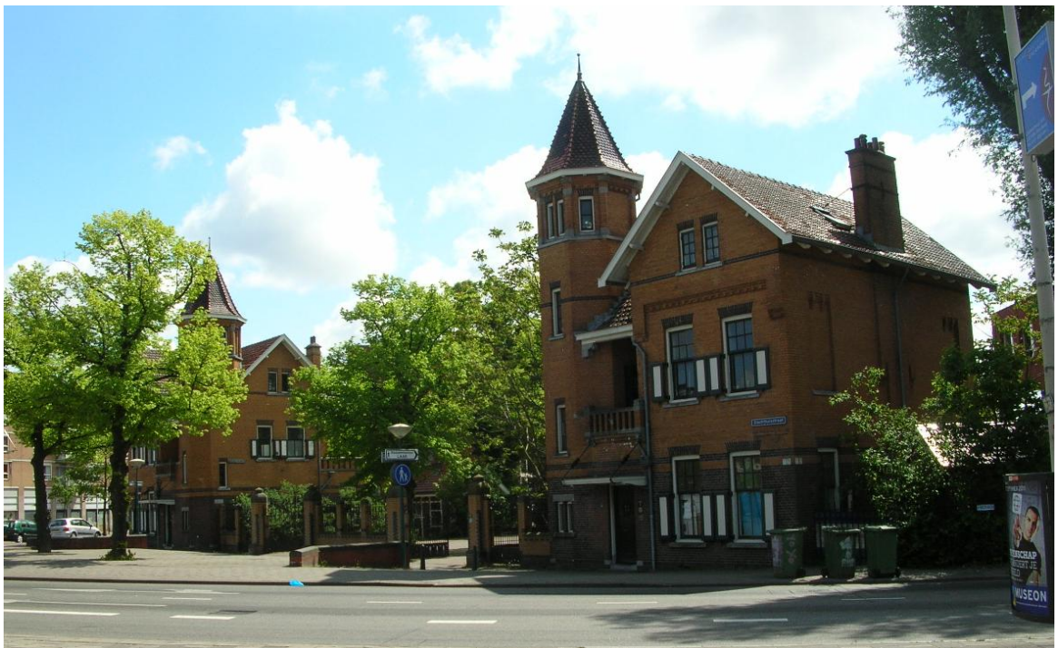
figuur 4.28 afbeelding van de villa's die fungeren als poortgebouw naar het Openbare Slachthuiscomplex
