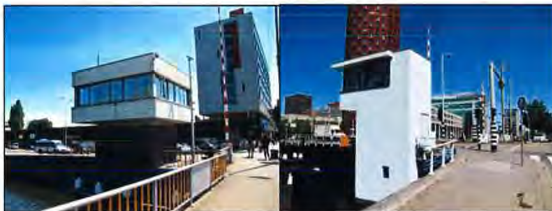
Figuur 3.4 Besturingsgebouwen Laakbrug (links) en Leeghwaterbrug (rechts)
