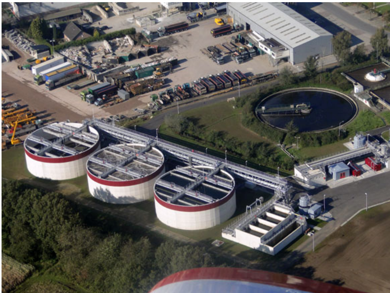
Figuur 7.1 Afbeelding korrelreactoren (RWZI Epe)
