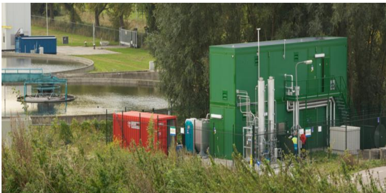
Figuur 7.2 Afbeelding cryogene installatie voor de opwerking van biogas naar biobrandstof
