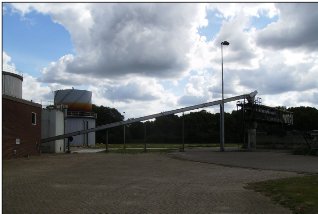
Afb.5. – Infra en verhardingen binnen het onderzoeksgebied
