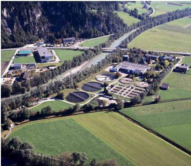
Afbeelding 1 RWZI Strass (Oostenrijk)
