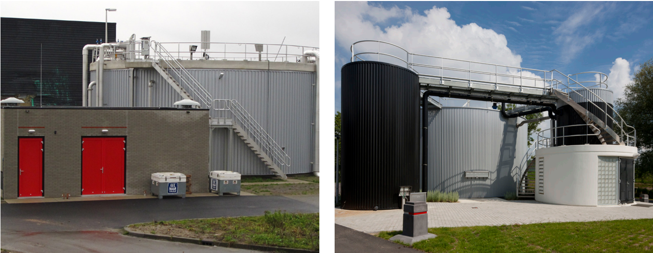
Afbeelding 9 Voorbeelden DEMON®-reactor
