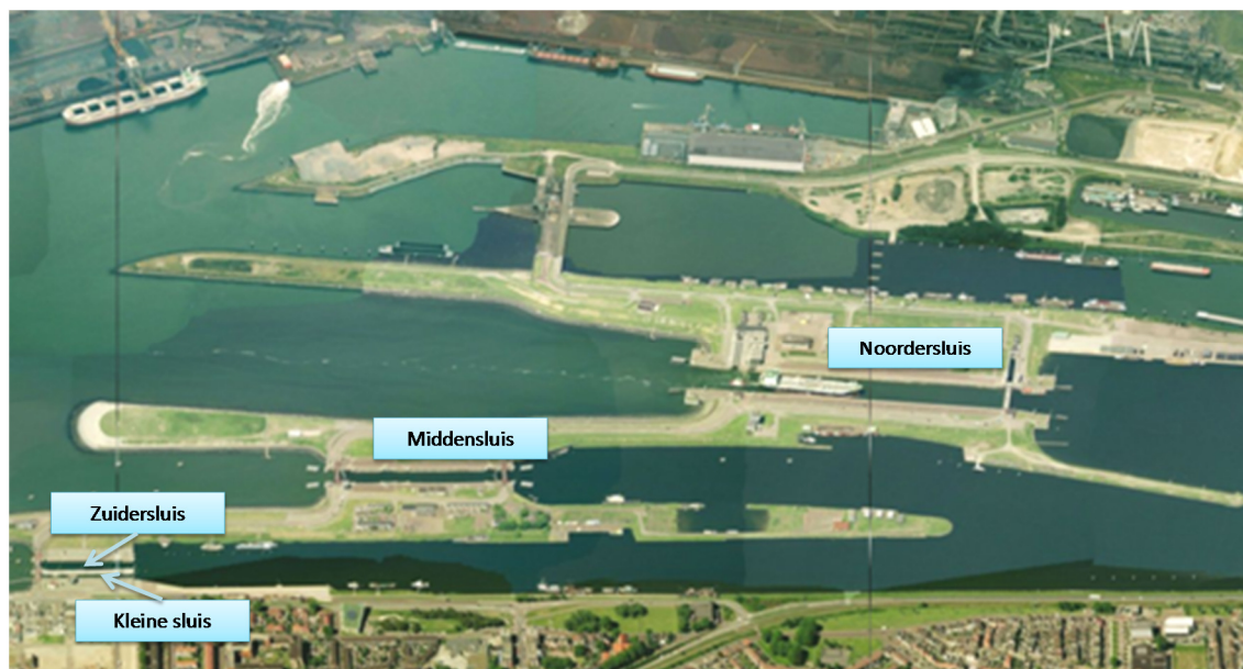
Figuur 2-2 Overzicht sluizencomplex IJmuiden
