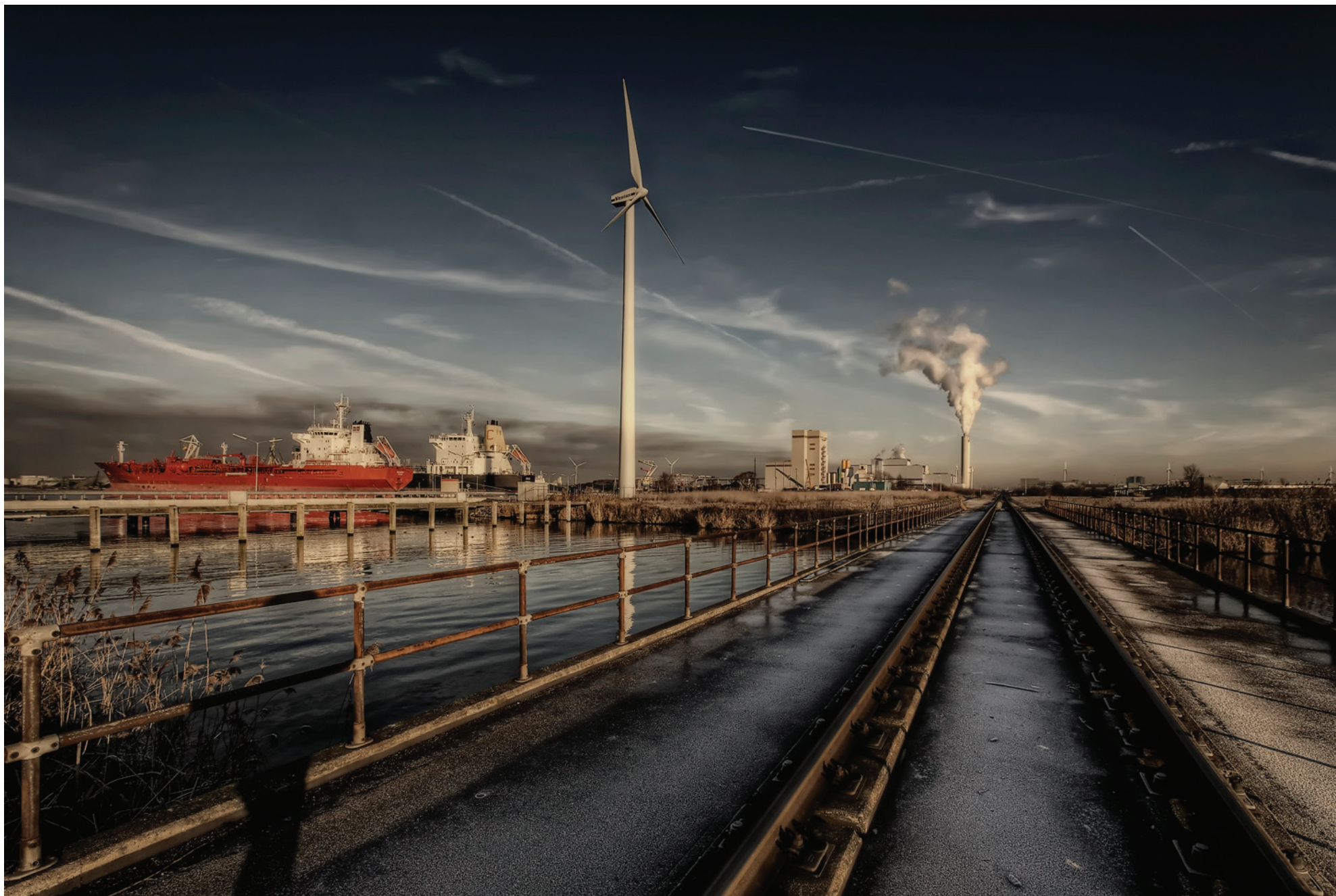
c Bestaande windmolen in het Westelijk Havengebied
