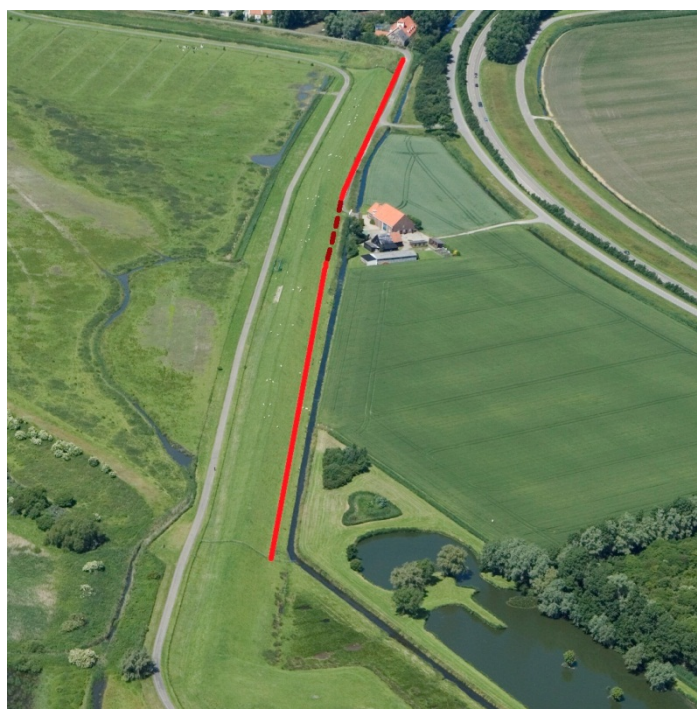
Afbeelding 15 Binnendijkse berm in combinatie met damwand t.p.v. boerderij
