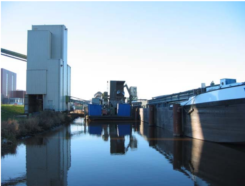
Figuur 5-15 Silo Fuite
