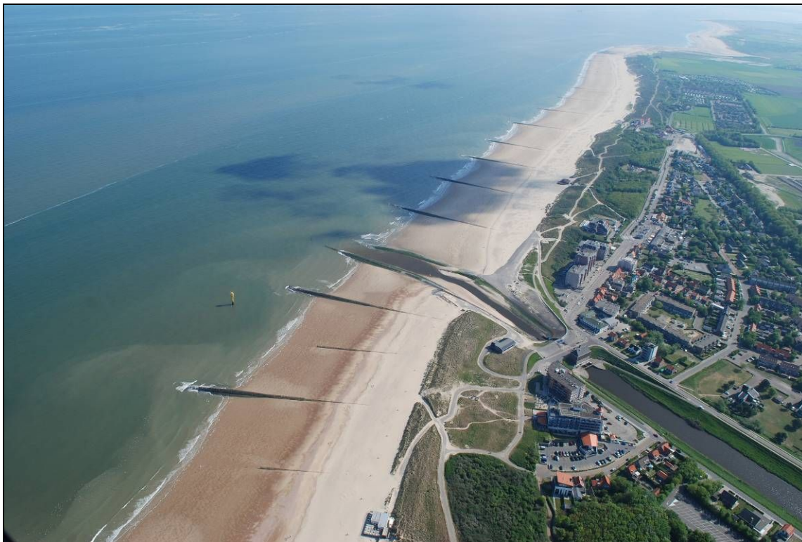
Figuur 1.1 Luchtfoto van het plangebied [Waterschap Scheldestromen]
